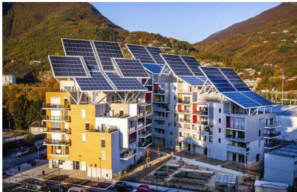
Immeuble ABC à Grenoble, développé par Bouygues
