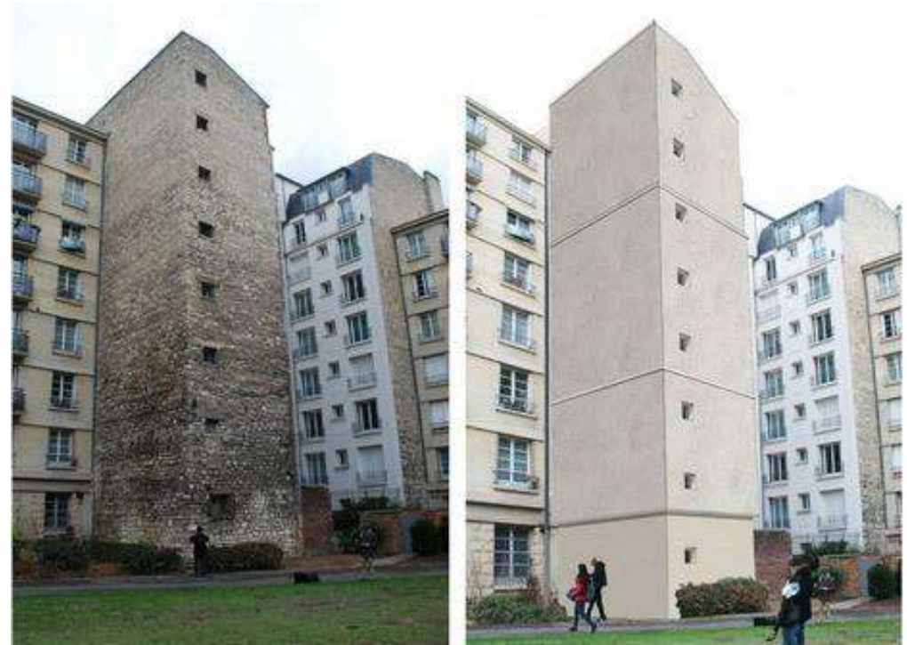
Rénovation d'une façade en bottes de paille sous enduites (Paris), Collect'if Paille.
